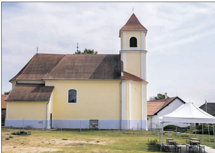
A szóládi templom is a Mindszent kolostor köveiből épült
