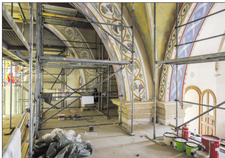
A székesegyház díszítőmotívumaihoz sablonok készültek, a stilizált növényi mintákat lézervágóval vágják ki
