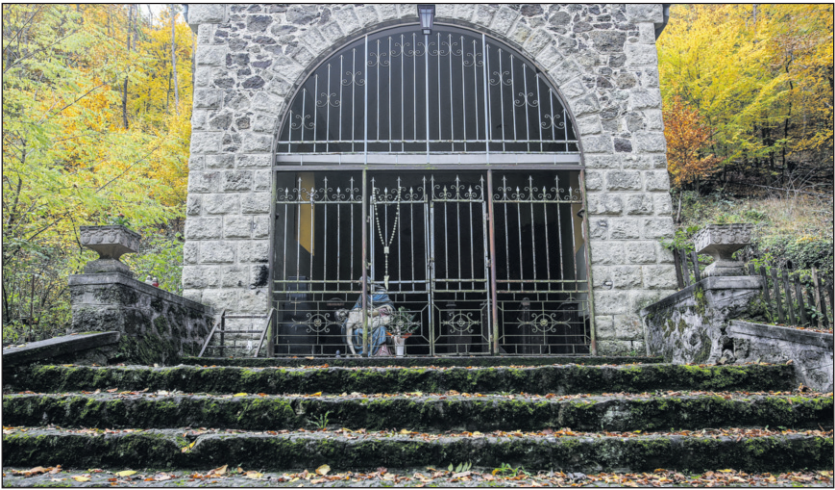
Szükségessé vált a Kálváriakápolna felújítása
